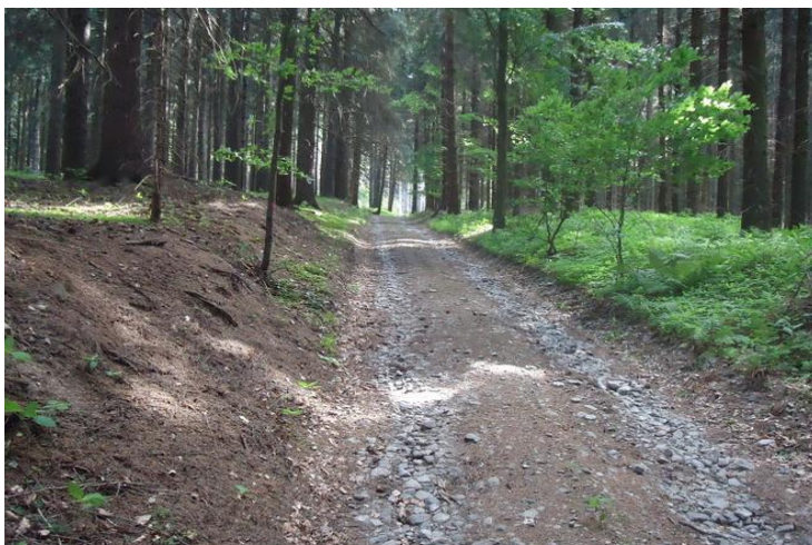
Obrázek č. 3: Lesní cesta 3. třídy (zdroj: aquasys-lesostavby)
