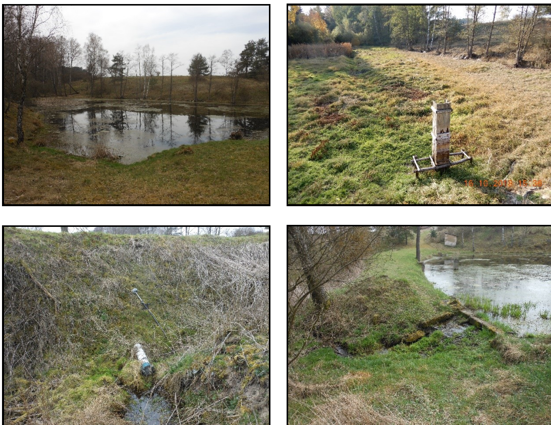
Obrázek č. 34 rybník Pod rampou vlevo nahoře rybník v dubnu 2018, vpravo nahoře rybník v říjnu 2018 vlevo dole vyústění odpadu požeráku, vpravo dole přeliv rybníka
