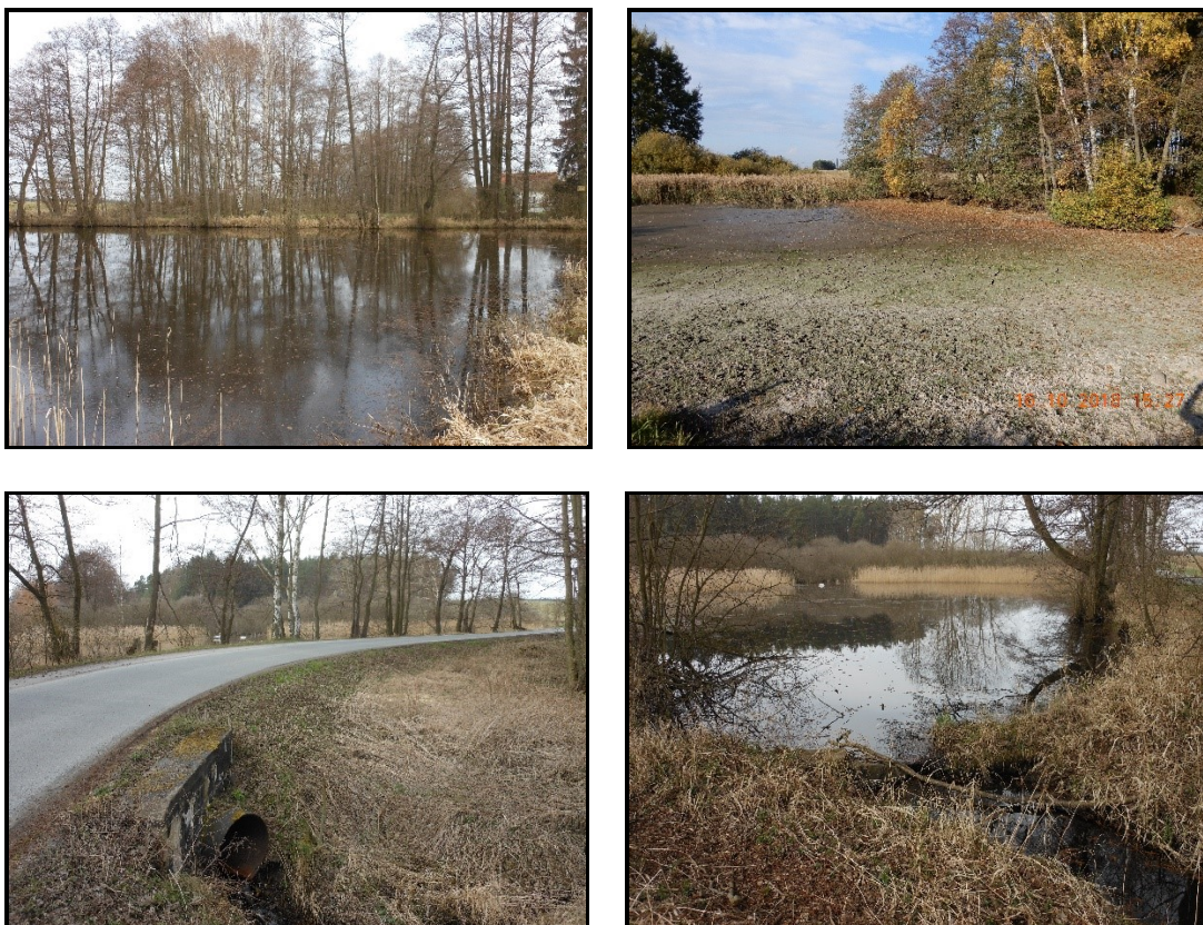
Obrázek č. 26 rybník U silnice vlevo nahoře stav v dubnu 2018, vpravo nahoře stav v říjnu 2018 vlevo dole hráz se silnicí a propustkem, vpravo dole přeliv rybníka
