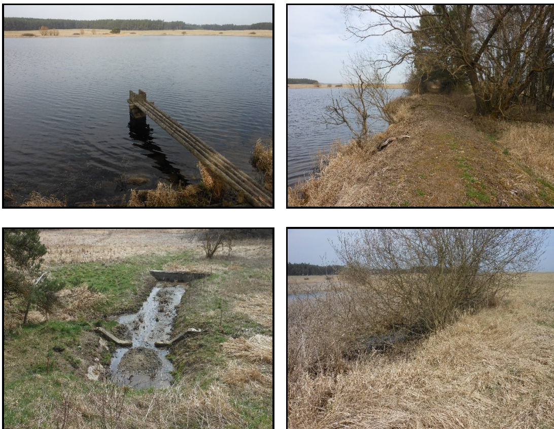
Obrázek č. 17 Velký rybník (duben 2018) vlevo nahoře pohled na rybník od výpusti, vpravo nahoře hráz rybníka vlevo dole odpadní kanál výpusti, vpravo dole prostor přelivu
