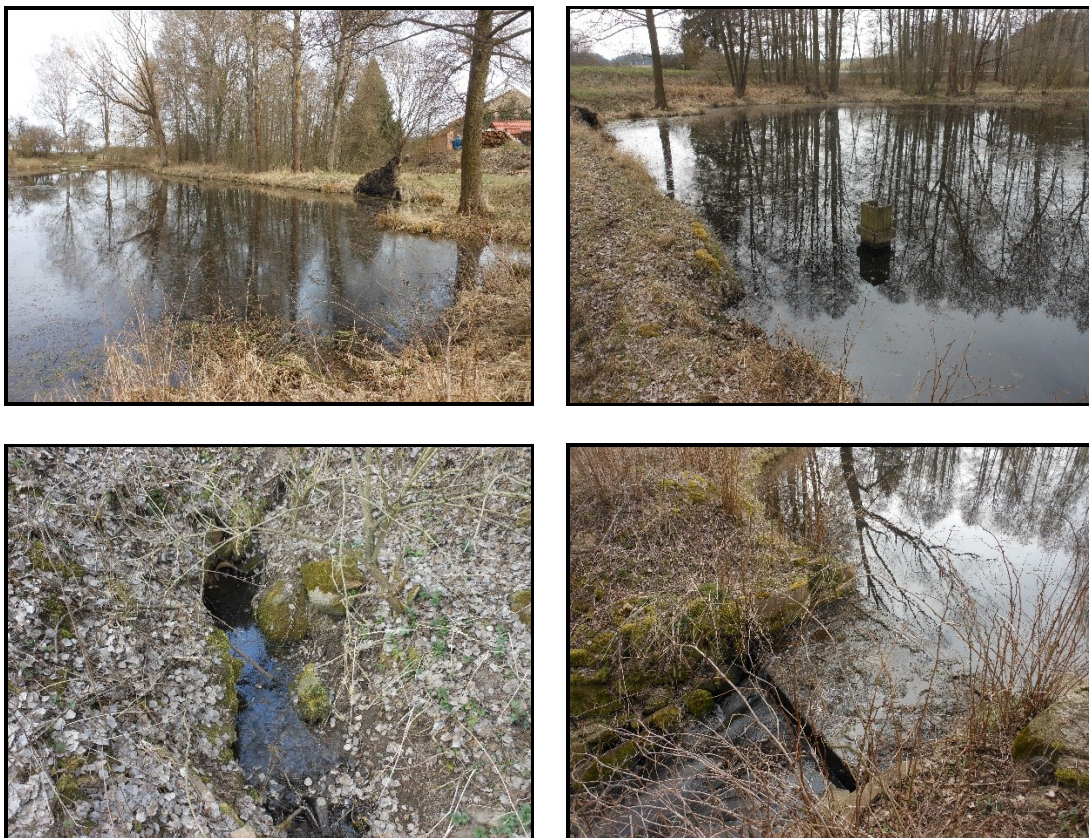
Obrázek č. 30 rybník Pod silnicí vlevo nahoře rybník v dubnu 2018, vpravo nahoře požerák rybníka vlevo dole vyústění odpadu požeráku, vpravo dole přeliv rybníka
