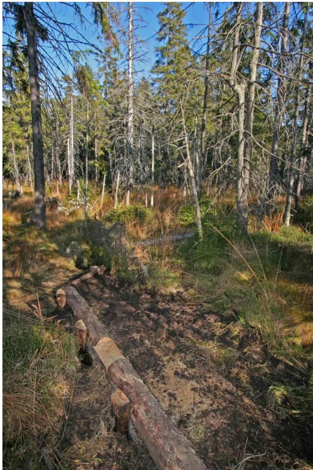
Obr. 10: Obnova vodního režimu rašelinné smrčiny, lokalita “Velká Kleč”, NPR Božídarské rašeliniště.
