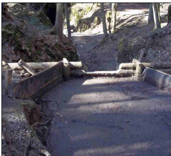
Obr. 4.8: Kal z ČOV nahromaděný za přehrážkou na Rudickém potoce.
