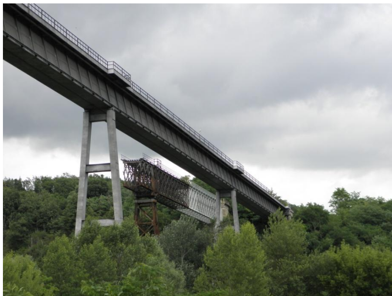
Obrázek č. 7: Ivančický viadukt (Zdroj: Lukáš Glóckner)
