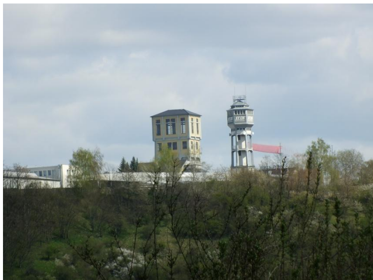
Obrázek č. 4: Věže dolu Kukla – Permonium (Zdroj: vlastní)
