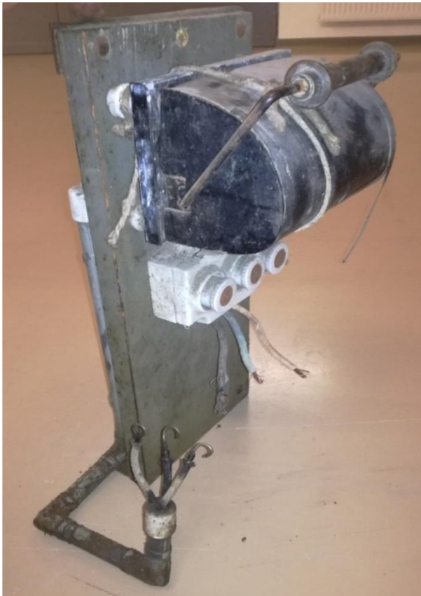
Obrázok 3.8: Nožový vypínač s poistkami pre renováciu
