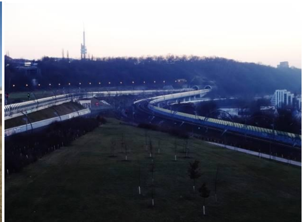
Obr. 120 Žižkovská věž zde vyniká v podstatě jen v noci. (foto: Anežka Hladová, 2016)
