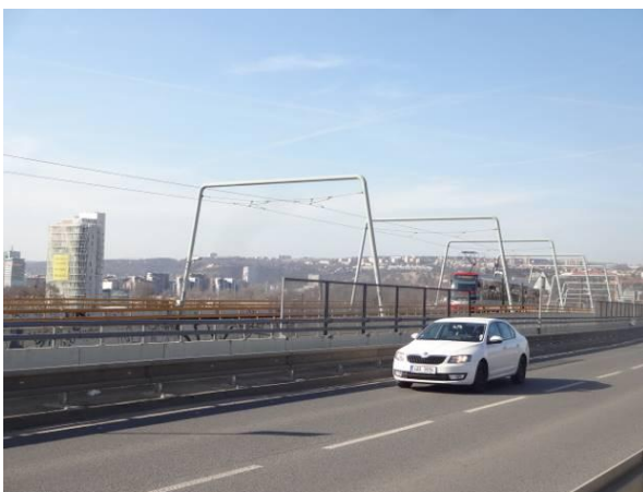
Obr. 121 Ani na mostě se nelze soustředit na výhled na Prahu. (foto: Anežka Hladová, 2017)
