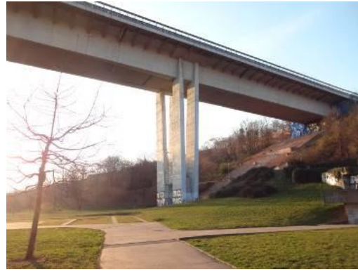
Obr. 108 Před mostem se v ploše parku nedá schovat. (foto: Anežka Hladová, 2016)
