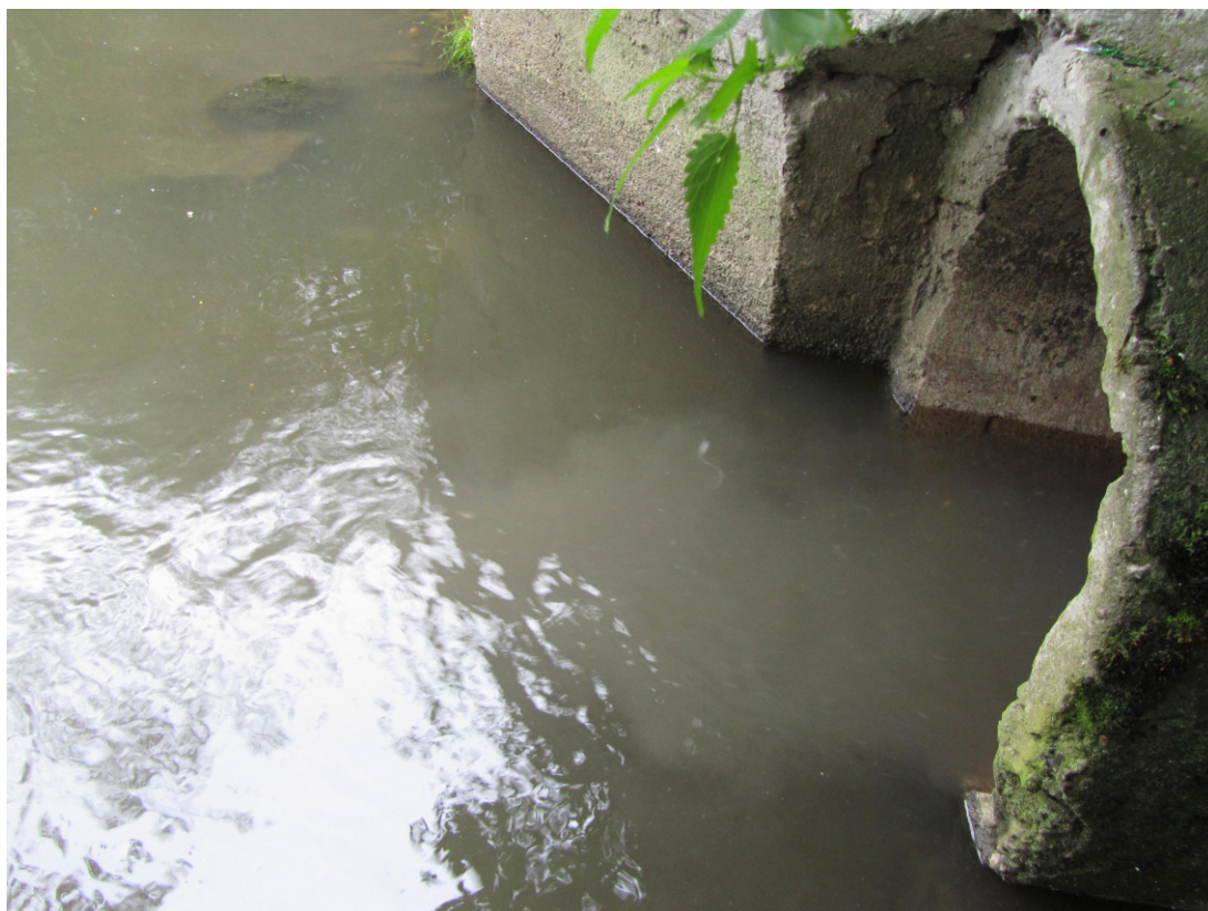
Obrázek 6. Znečištění řeky Střely odlehčením kanalizačního řádu nad ČOV v Toužimi. Zdroj: Autor, 18. 9. 2013.
