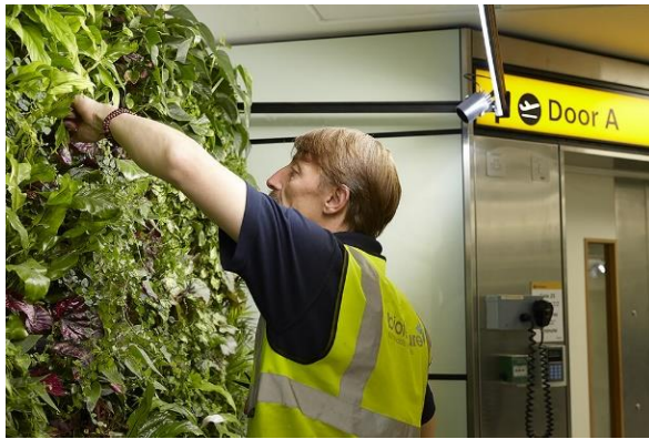
Obr. 4 Instalace panelových systémů s hydroponickým systémem Grodan, firma Biotecture ( http://www.biotecture.uk.com/hydroponic-living-walls/ ).
