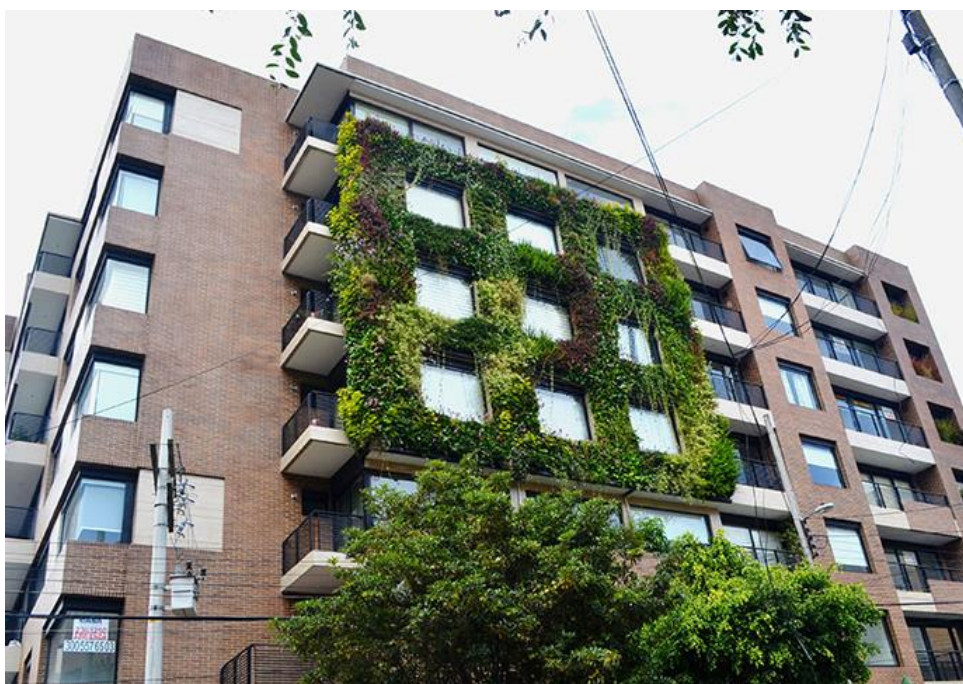
FOTO 36: Dokončení zelené fasády, Caminos de Bella Suiza, Columbia, 2015 ( http://www.paisajismourbano.com/en/caminos-de-bella-suiza-green-facade-in-colombia ).
