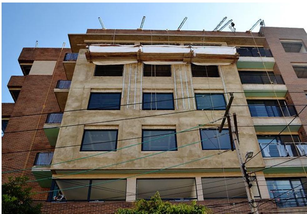
FOTO 35: Výstavba zelené fasády, Caminos de Bella Suiza, Columbia, 2015 ( http://www.paisajismourbano.com/en/caminos-de-bella-suiza-green-facade-in-colombia ).
