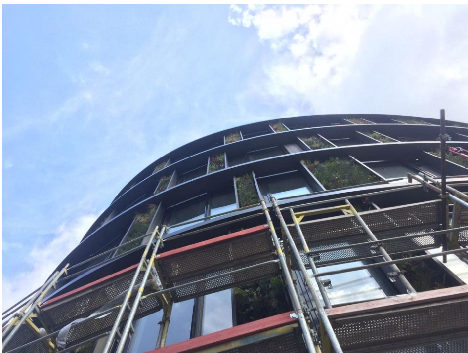
FOTO 45: Kancelářská budova Butterfly, realizace 2017, Praha (zdroj: autor).
