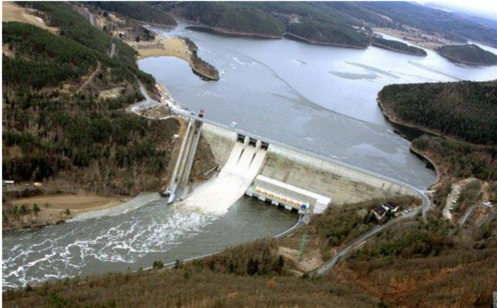
Obrázek 6 Vodní elektrárna Orlík
