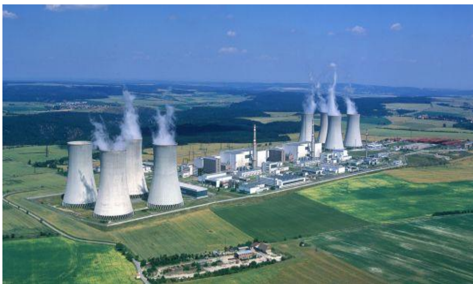
Obrázek 2 Jaderná elektrárna Dukovany
