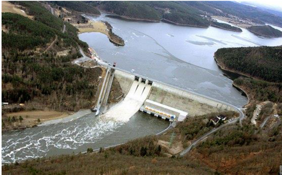
Obrázek 6 Vodní elektrárna Orlík
