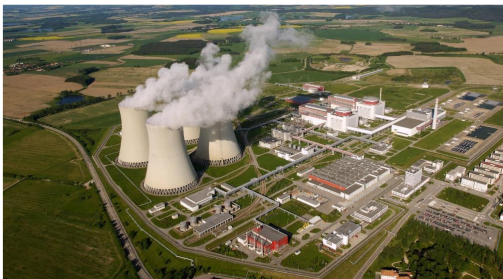
Obrázek 3 Jaderná elektrárna Temelín
