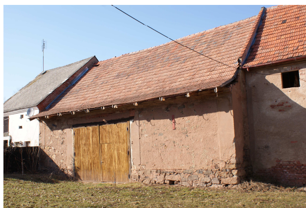
Obrázek 3 – Hospodářská budova, část pro skladování sena (Autor: Nikola Benedeková, 21.3.2013, Královské Údolí)
