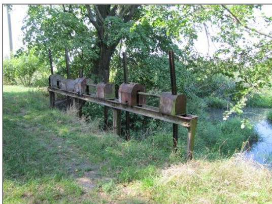
Obr. 3.34: Stavidlový most ř. km 4,574
