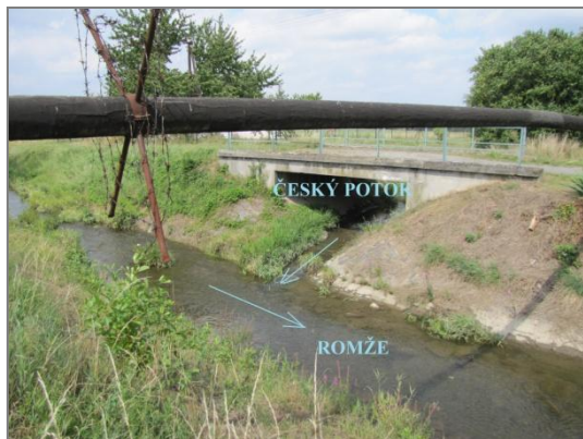
Obr. 3.3: Soutok Českého potoka a Romže
