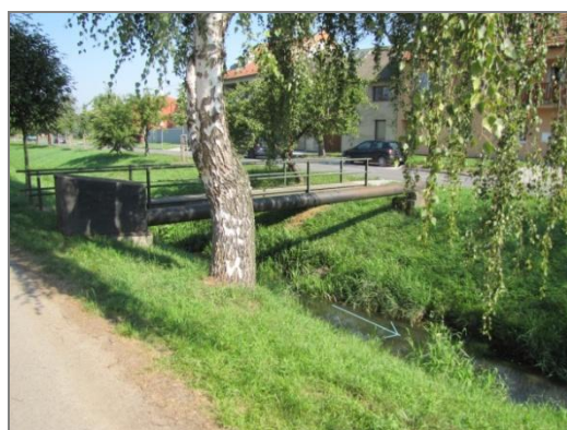
Obr. 3.11: Nadzemní potrubí ř. km 2,173 a lávka ř. km 2,176
