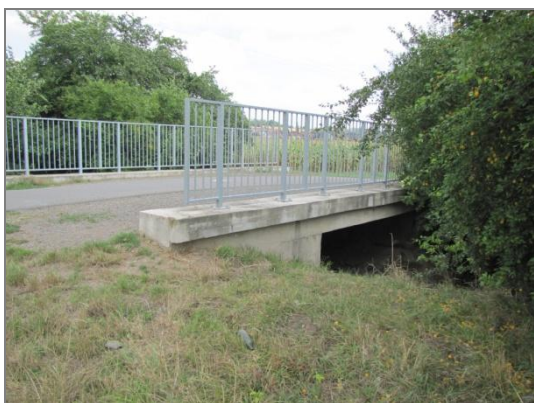
Obr. 3.5: Most na cyklostezce ř. km 0,259
