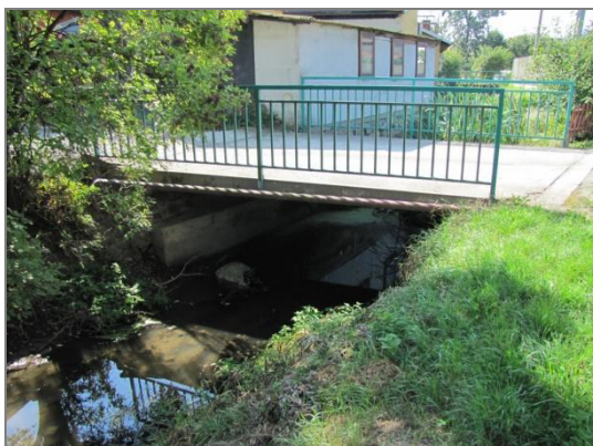
Obr. 3.18: Most ř. km 2,711
