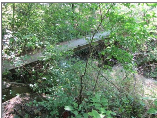
Obr. 3.30: Lávka ř. km 4,263
