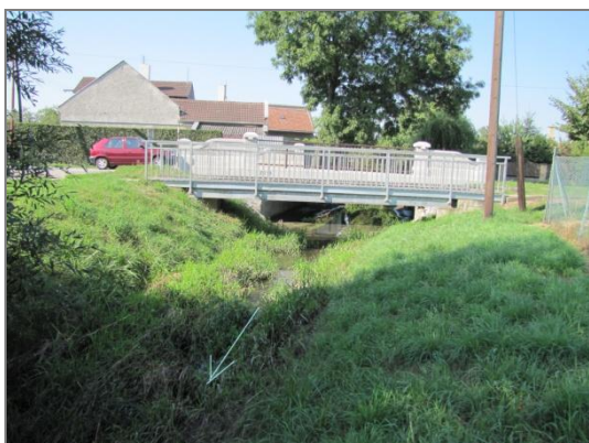
Obr. 3.14: Lávka ř. km 2,561
