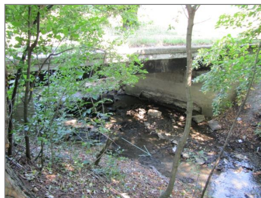
Obr. 3.23: Hospodářský most ř. km 3,313
