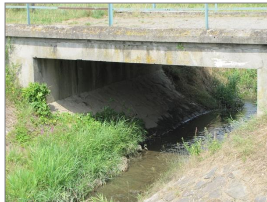
Obr. 3.4: Hospodářský most ř. km 0,009 HOSPODÁŘSKÝ MOST ř. km 0,009
