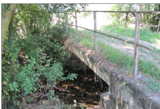
Obr. 3.28: Hospodářský most ř. km 3,987
