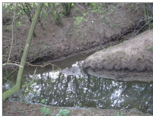
Obr. 3.25: PB Mlýnská strouha ř. km 3,712 [18]
