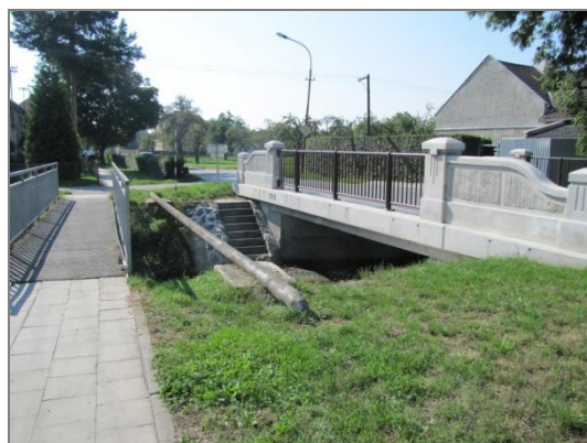
Obr. 3.15: Silniční most ř. 2,570, lávka ř. km 2,561 a nadzemní potrubí ř. km 2,563 a ř. km 2,565
