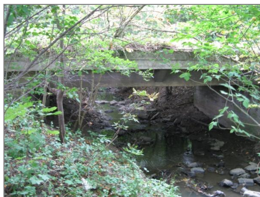
Obr. 3.31: Hospodářský most ř. km 4,413
