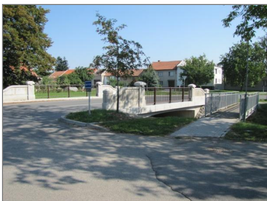
Obr. 3.12: Lávka ř. km 2,293 a silniční most ř. km 2,302
