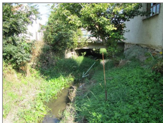
Obr. 3.17: Most ř. km 2,672
