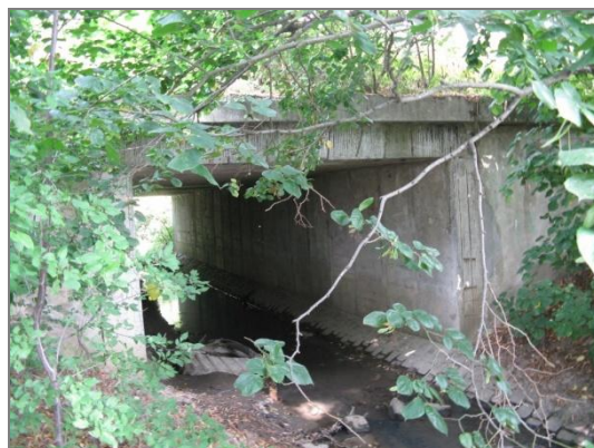
Obr. 3.35: Silniční most ř. km 4,897[18]
