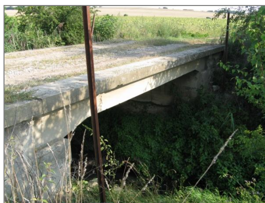
Obr. 3.7: Hospodářský most ř. km 0,838 [18]
