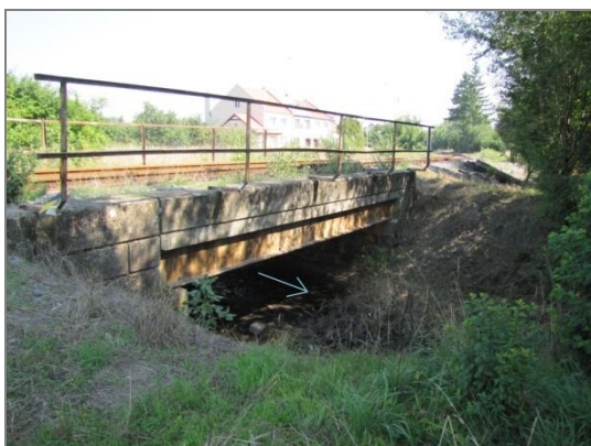
Obr. 3.26: Železniční most ř. km 3,912
