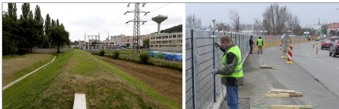
Obr. 4.1: Ukázka ochranné hráze [12] a mobilního protipovodňového hrzení[19]
