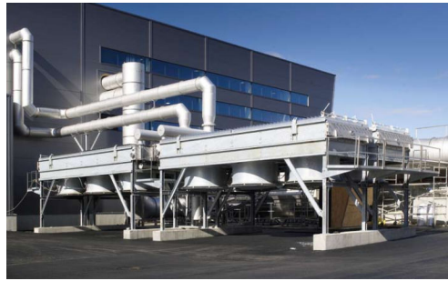
Obrázek 13: Horizontální kondenzátor[11]
