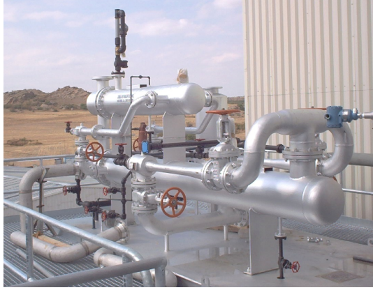
Obrázek 9: Nádrž na kondenzát[2]
