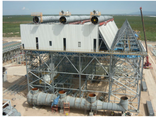
Obrázek 10: Stavba kondenzátoru[2]
