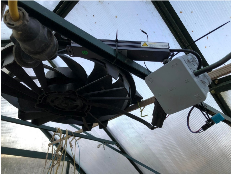
Obrázek 40 ESP_SKL1_Teplota uvnitř skleníku. Zdroj: Vlastní
