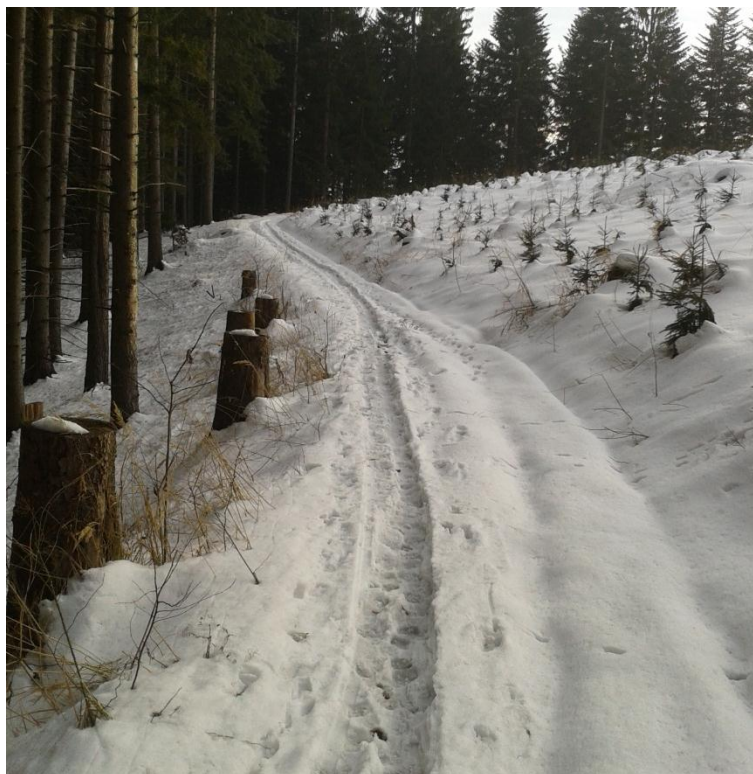
Obrázek 27: Lesní cesta mezi Střelenským vrchem a Čubovým kopcem. Bohužel ukázka neohleduplnosti pěších turistů, jezdců na koních a běžkařů v zimním období
