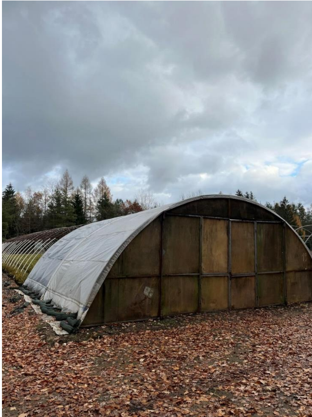
Obr.18: Ukázka zpracování konstrukce fóliovníku, Planá nad Lužnicí (archiv autora)
