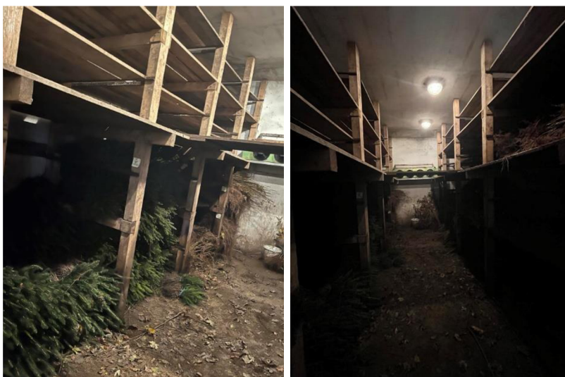
Obr. 16 a 17: Ukázka Klimatizovaného zařízení pro skladování sazenic, Planá nad Lužnicí (archiv autora)
