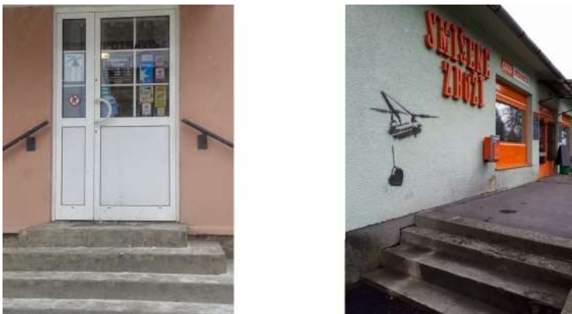
Obr. 3 Absence bezbariérového přístupu do prodejny Zdroj: fotografie autorky práce, samoobsluha na vesnicích
