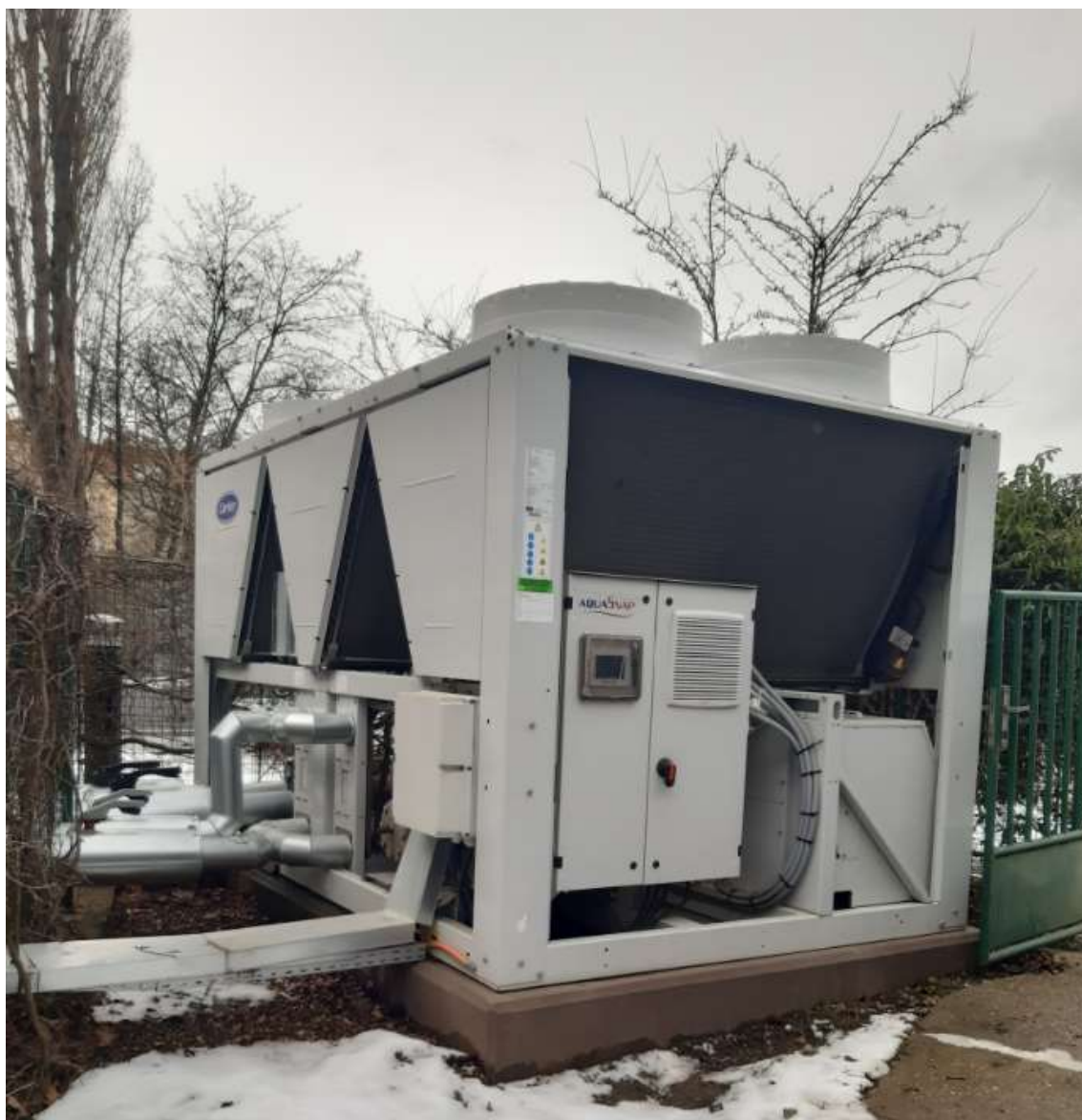
Obrázek 30- Tepelné čerpadlo firmy Carrier 30RQP-0270-A [41]
