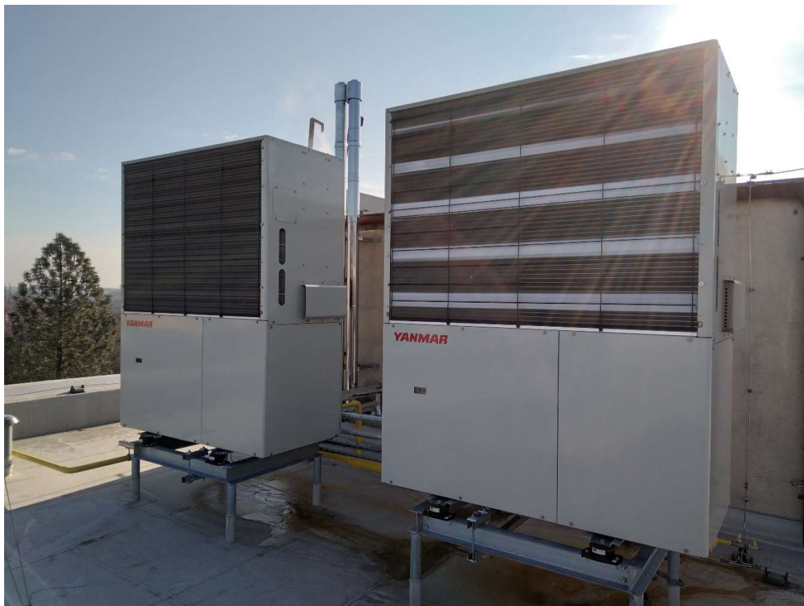
Obrázek 31 – Plynové tepelné čerpadla Yanmar
