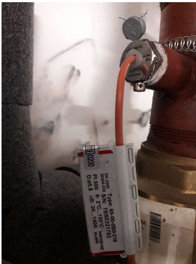
Obrázek 20 - zaplombované teplotní čidlo pro kalorimetr [40]
