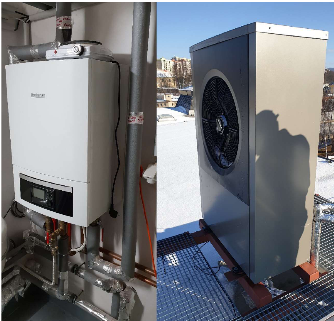
Obrázek 18 - Vnitřní (nalevo) a venkovní (napravo) jednotka tepelného čerpadla [40]
