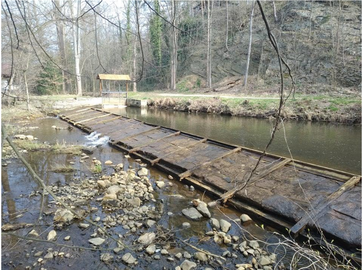
Obr. 10 Jez 21 a náhon do vodní elektrárny (Zdroj: Monika Doudová, 2020)
