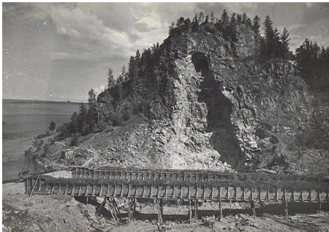
Obr. 4 Silniční tunel u vodní nádrže Seč při výstavbě hráze (Zdroj: www.mestosec.cz , 1925)
