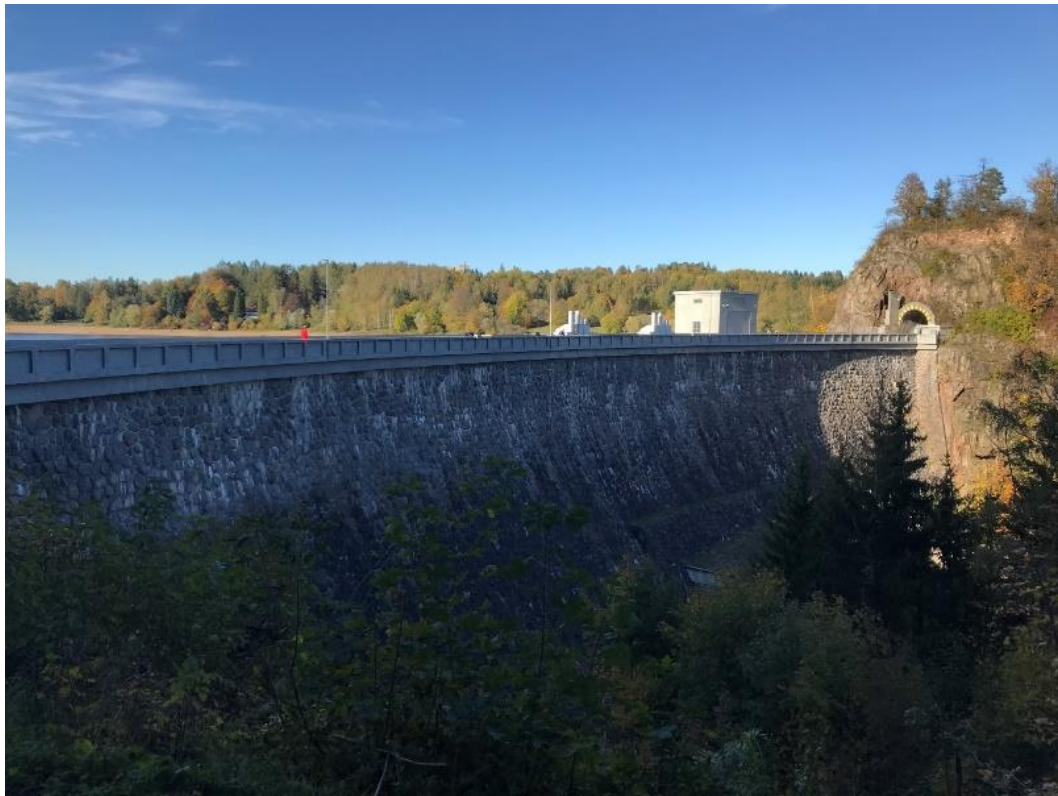
Obr. 3 Hráz vodní nádrže a silniční tunel Seč (Zdroj: Monika Doudová, 2019)
