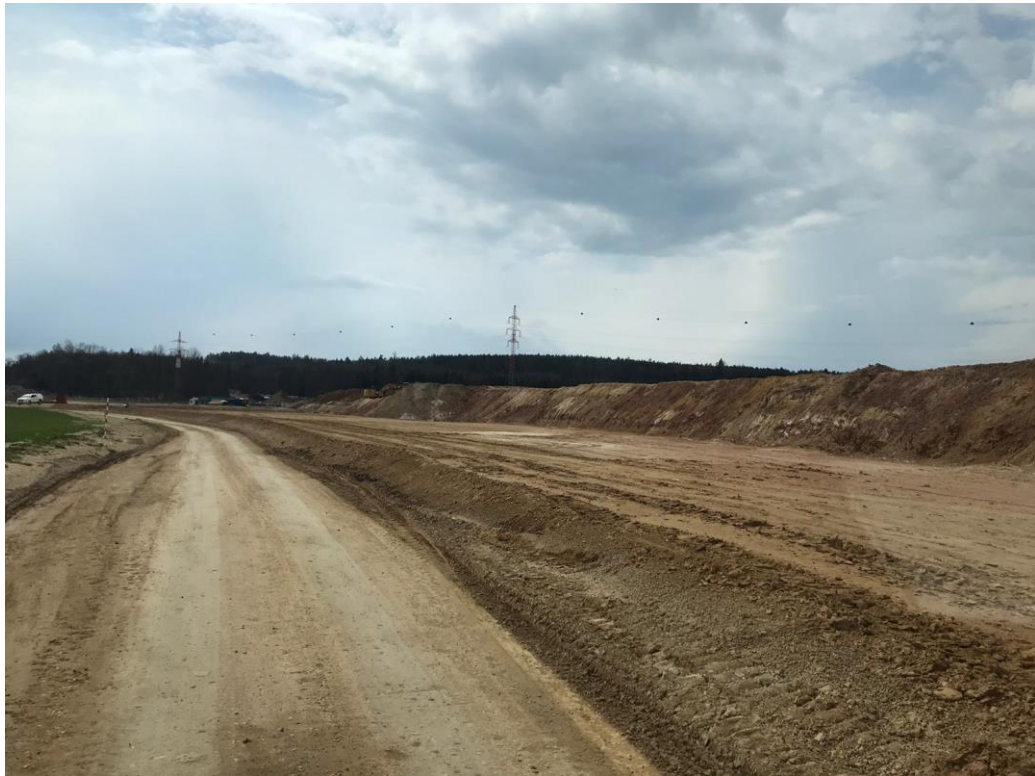
Obrázek 10.1 Rozestavěná dálnice D3, úsek Staré Hodějovice - Roudné (foto vlastní)
