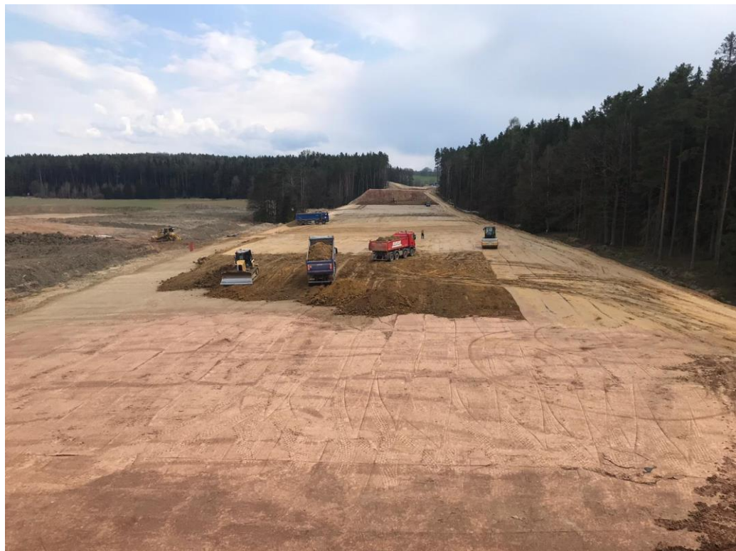
Obrázek 10.2 Rozestavěná dálnice D3, úsek Staré Hodějovice - Roudné (foto vlastní)
