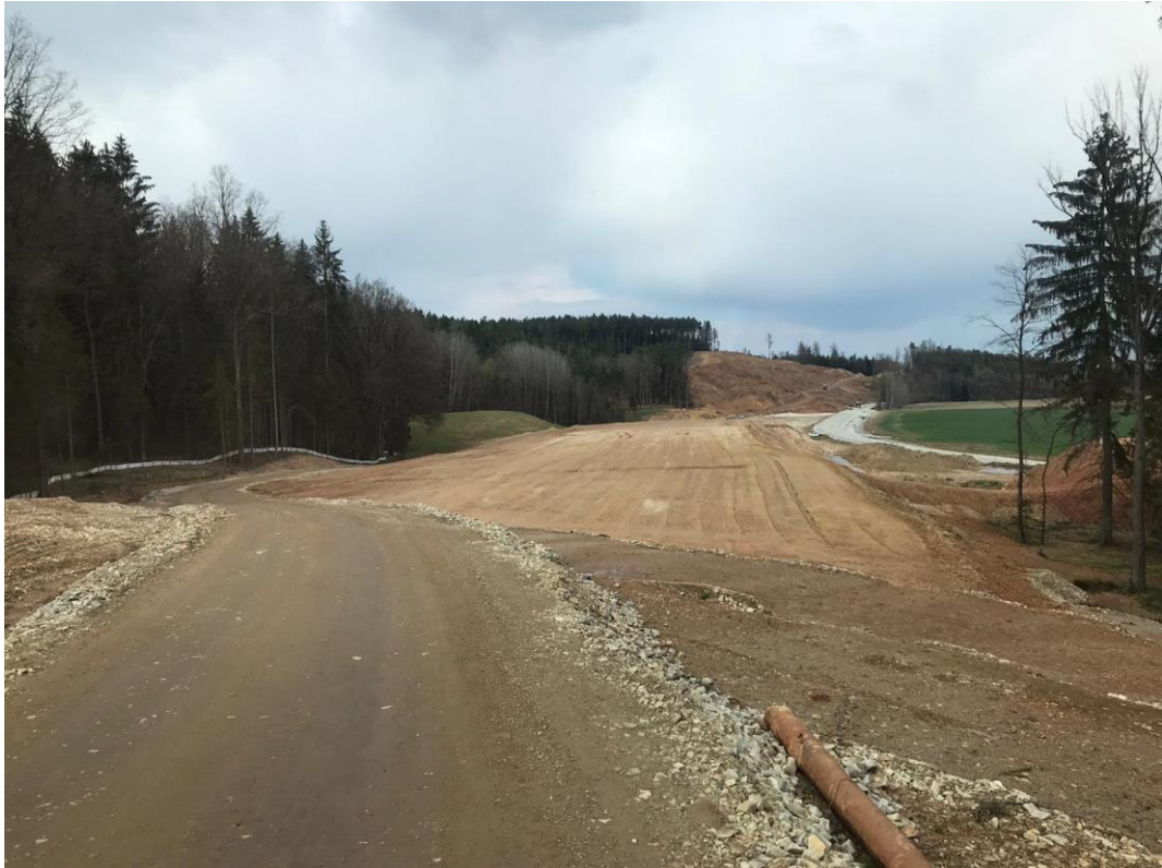
Obrázek 10.3 Rozestavěná dálnice D3, úsek Staré Hodějovice - Roudné (foto vlastní)
