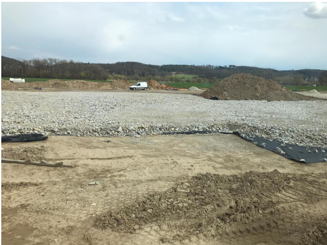
Obrázek 10.4 Rozestavěná dálnice D3, úsek Staré Hodějovice - Roudné, použití lomového kamene (foto vlastní)
