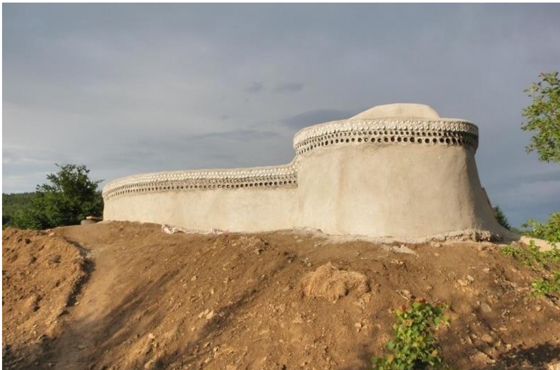
Obrázek 2.4 Zeměloď Zeměnka v průběhu stavby ( www.zemelod.cz )
