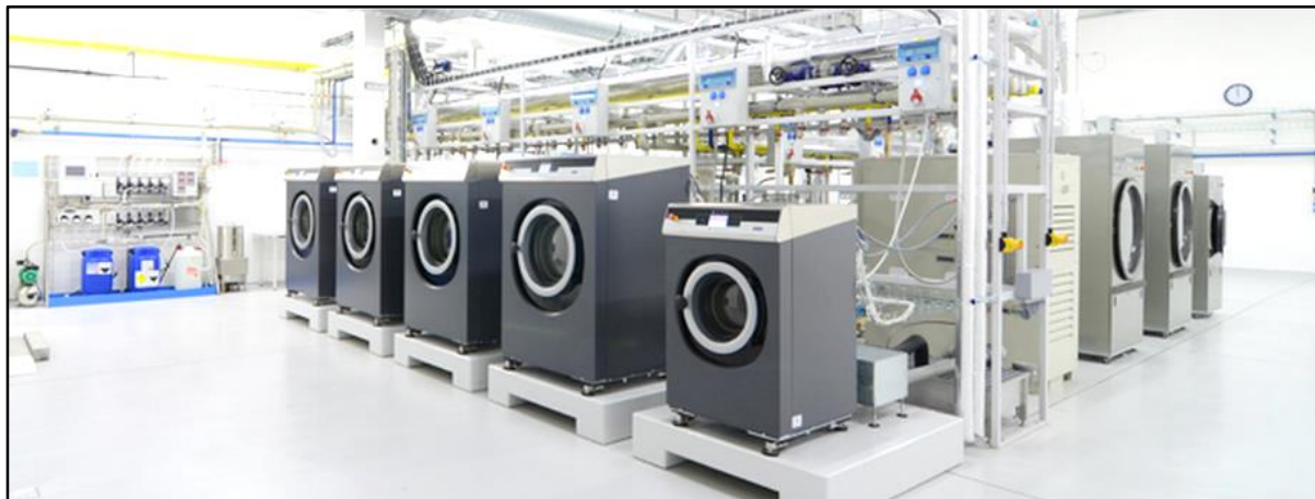
Obr. 1 Laboratoř energeticky náročných procesů [10]
