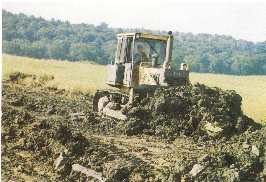
Selektivní skrývka ornice
