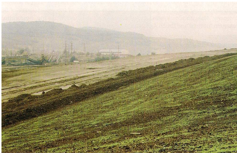
Jpravená výsyvka částečně překrytá orníci
