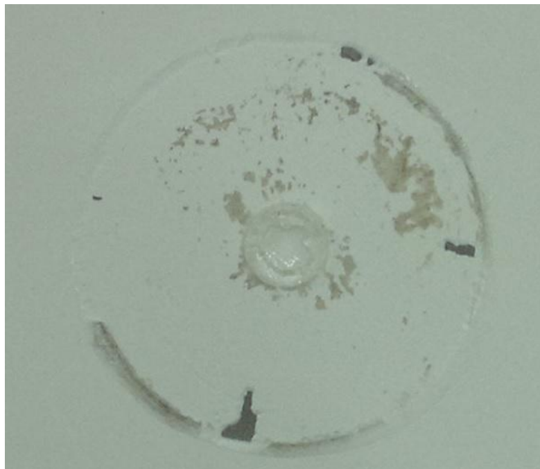
Obr. 54 Detail odtrhové zkoušky
