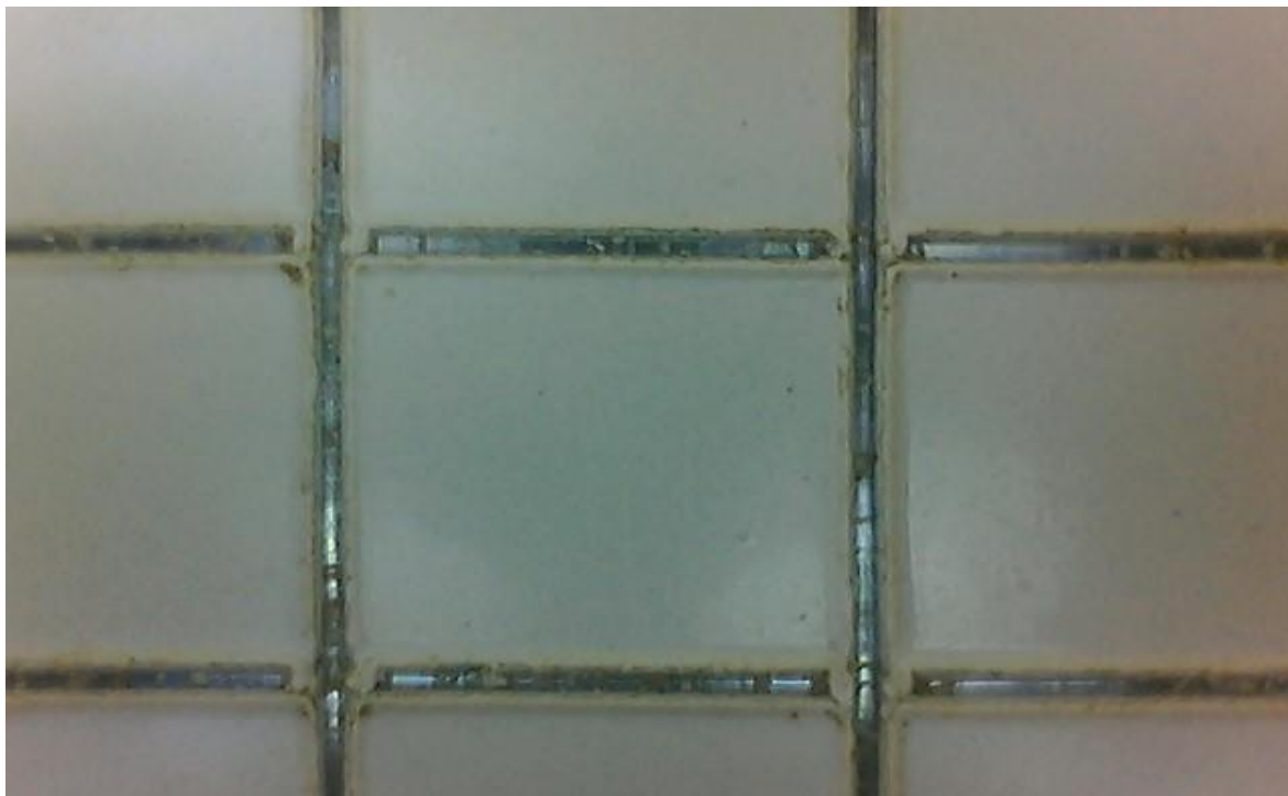
Obr. 45 Detail mřížkové zkoušky
