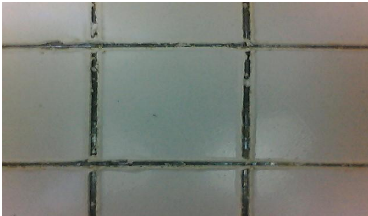
Obr. 47 Detail mřížkové zkoušky
