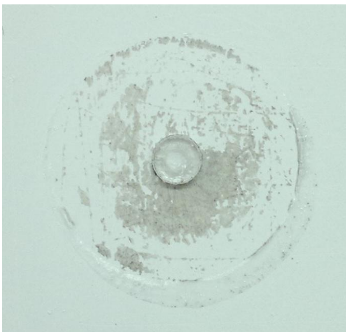
Obr. 53 Detail odtrhové zkoušky
