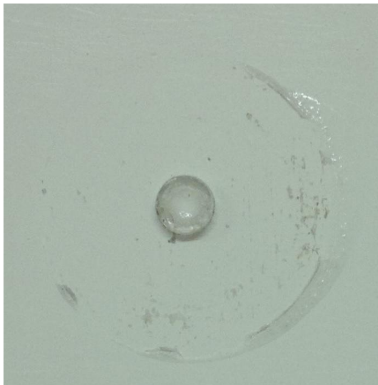
Obr. 50 Detail odtrhové zkoušky
