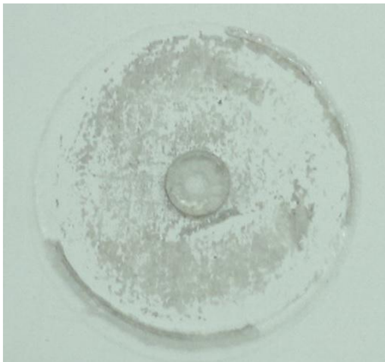
Obr. 55 Detail odtrhové zkoušky
