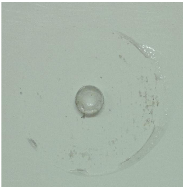
Obr. 50 Detail odtrhové zkoušky
