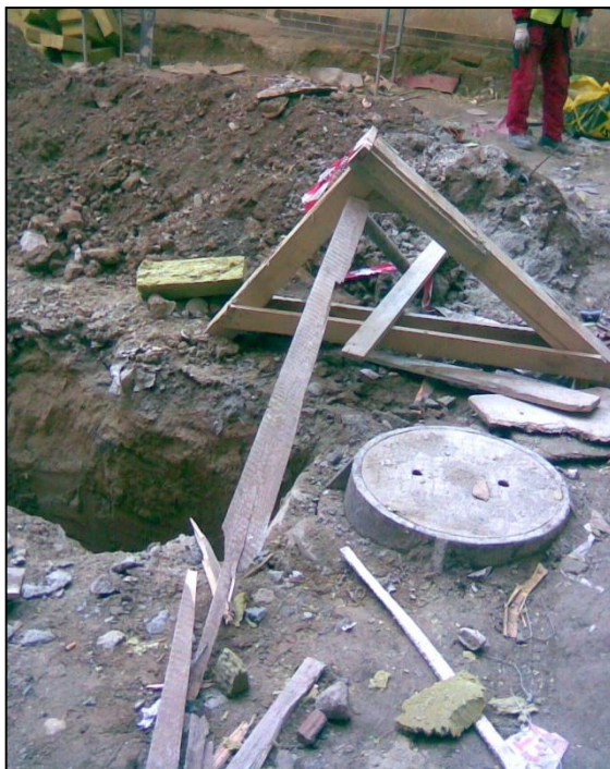
Obr. 6-7: Nedostatečné zábradlí
