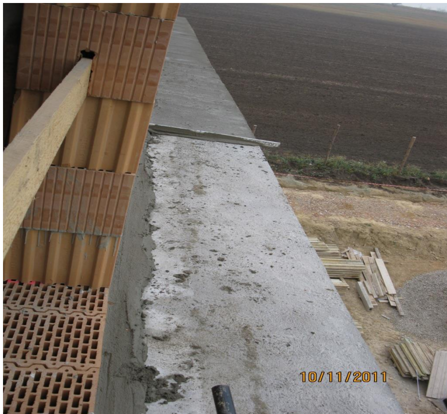
Obr. 6-21: Chybějící zábradlí
