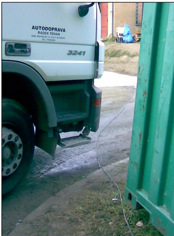
Obr. 6-15: Kabel volně položen na vozovce
