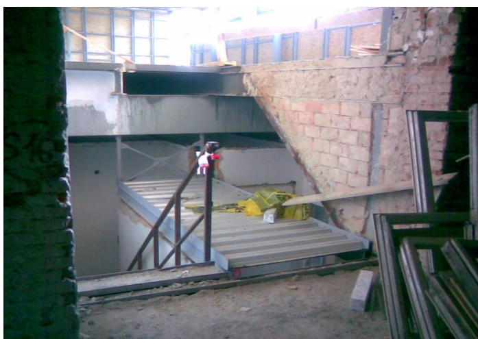
Obr. 6-6: Nedostatečné zábradlí
