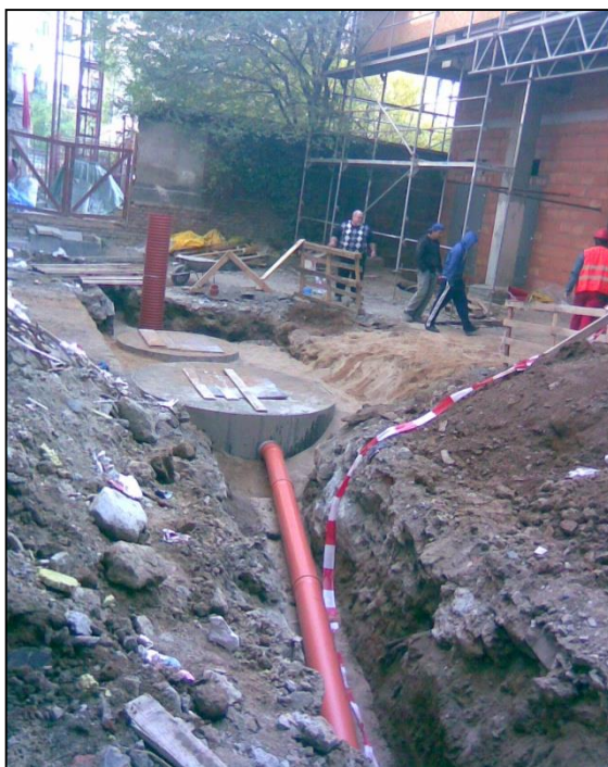
Obr. 6-8: Nedostatečné zábradlí
