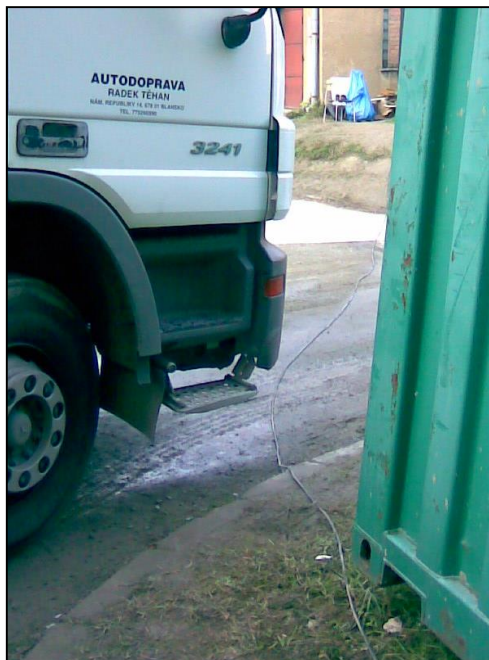
Obr. 6-5: Kabel volně položen na vozovce
