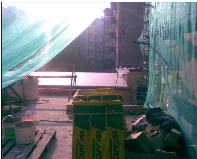
Obr. 6-9: Nedostatečné zábradlí
