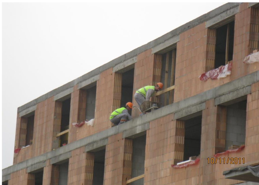
Obr. 6-18: Žádné zajištění proti pádu
