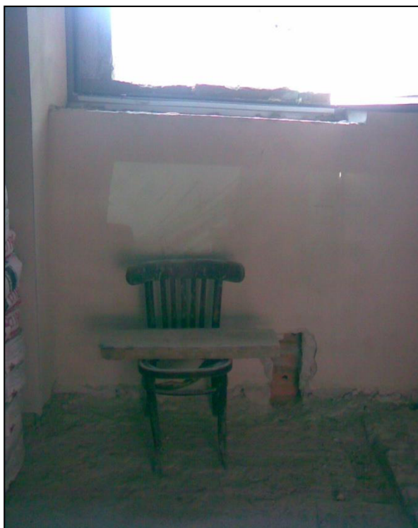
Obr. 6-10: Nevhodná konstrukce výlezu
