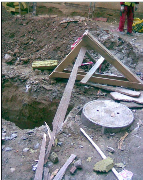
Obr. 6-7: Nedostatečné zábradlí
