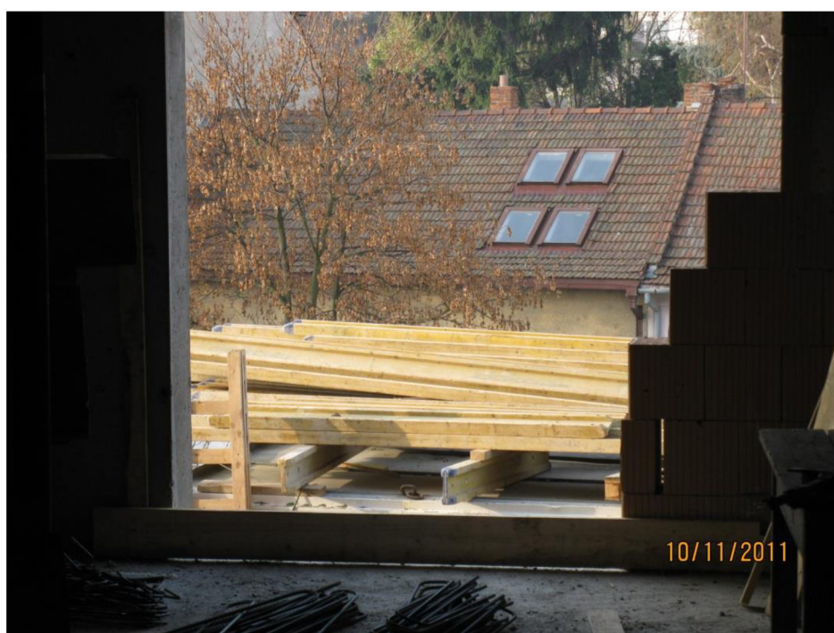
Obr. 6-23: Chybějící zábradlí
