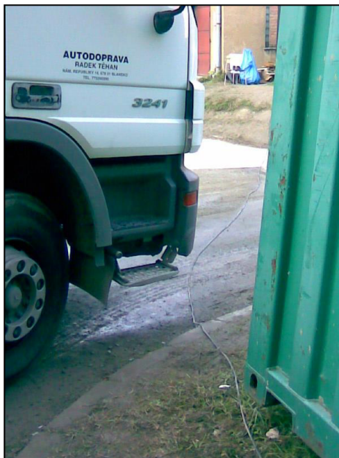
Obr. 6-5: Kabel volně položen na vozovce
