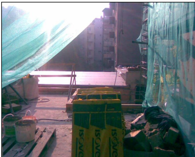
Obr. 6-9: Nedostatečné zábradlí
