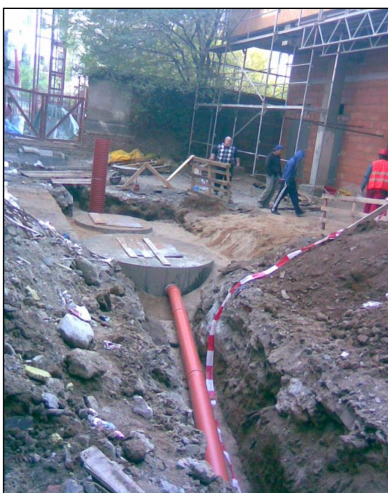
Obr. 6-8: Nedostatečné zábradlí
