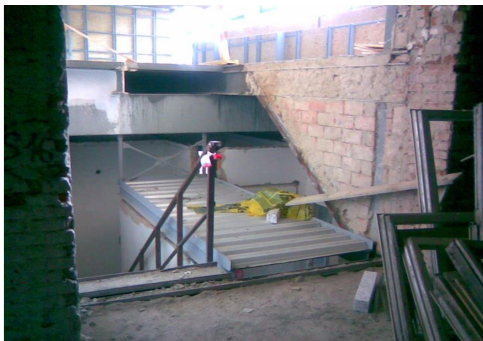
Obr. 6-6: Nedostatečné zábradlí
