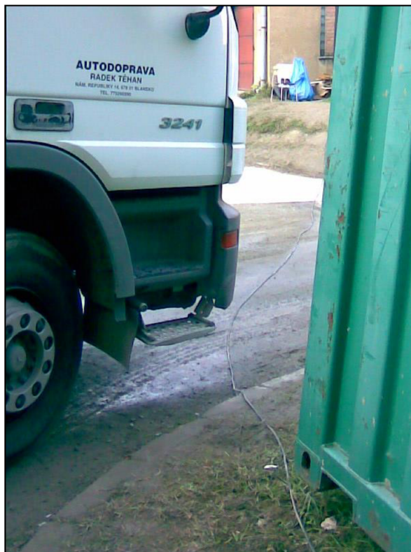
Obr. 6-15: Kabel volně položen na vozovce
