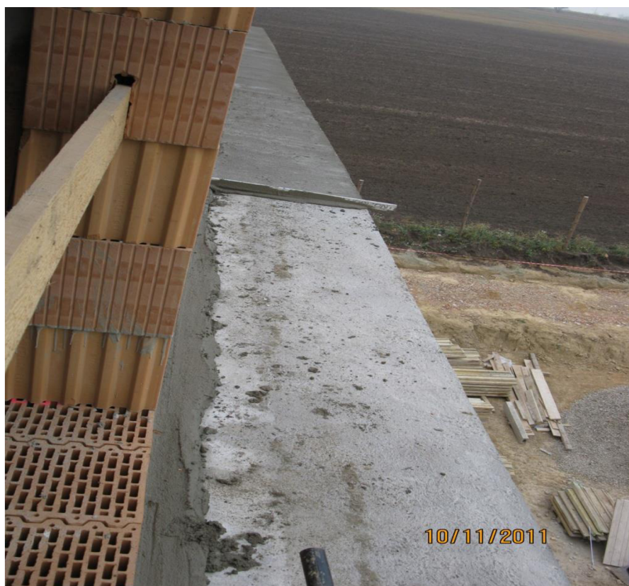
Obr. 6-21: Chybějící zábradlí
