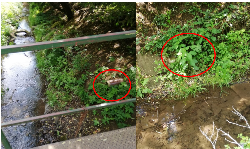
Obrázek 6 Výúst' vody ze studny (vlevo), výúst' šedých vod (vpravo) [zdroj: Krulová]
