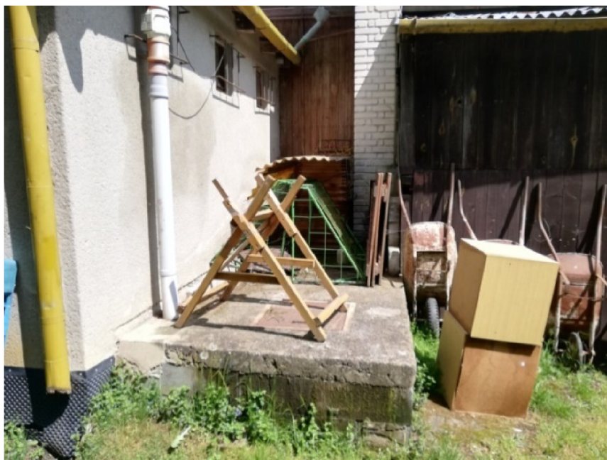
Obrázek 4 Stávající žumpa [zdroj: Krulová]
