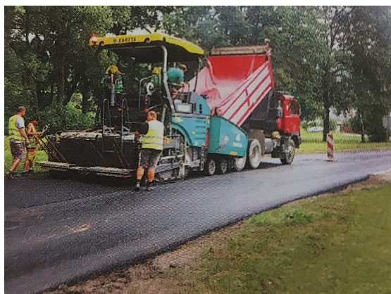
Obr. č. 3. Pokládka asfaltové vozovky (Zajíček, 2021)
