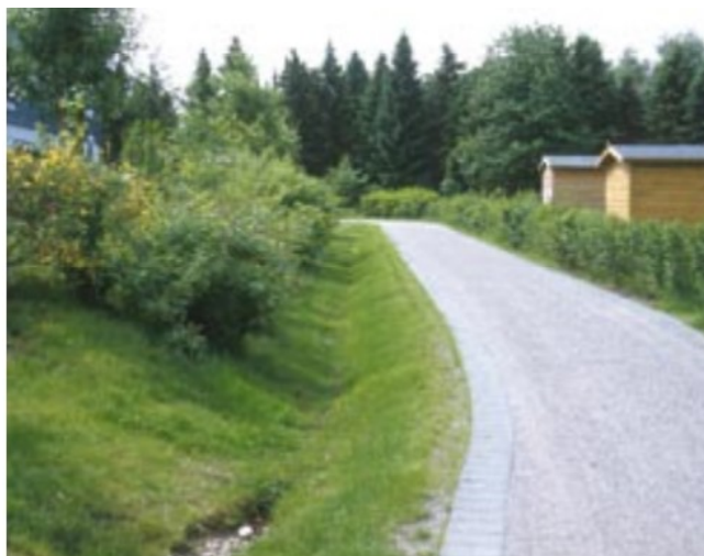
Obr. č. 8. Odvodňovací příkop podél komunikace (Meißner, 2006)
