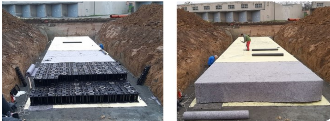
Obr. č. 18. Ukázka z realizace vsakovacích a retenčních objektů (Wavin, 2021)
