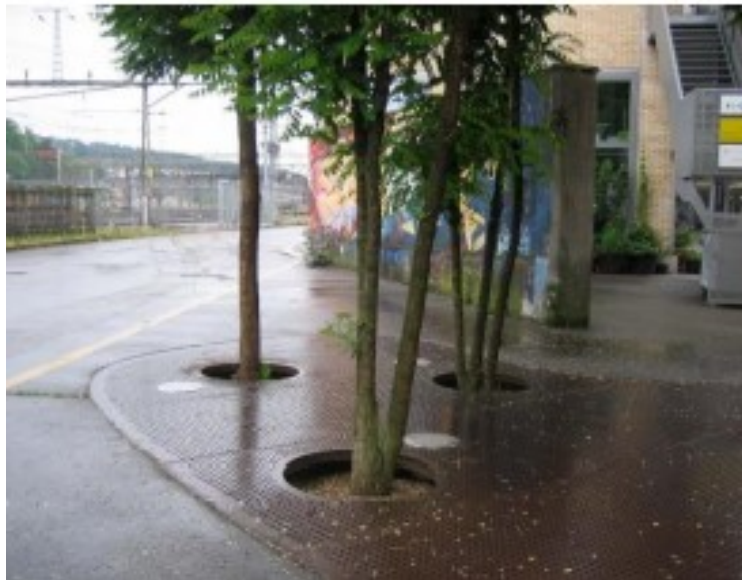
Obr. č. 14. Propustná dlažba Birkerød, Dánsko (Water Sensitive Urban Design in Denmark, 2011)
