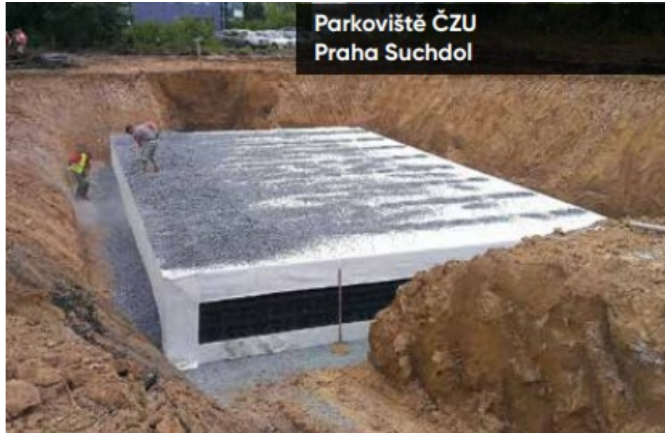
Obr. č. 17. Ukázka z realizace vsakovacích a retenčních objektů (Nikoll, 2021)
