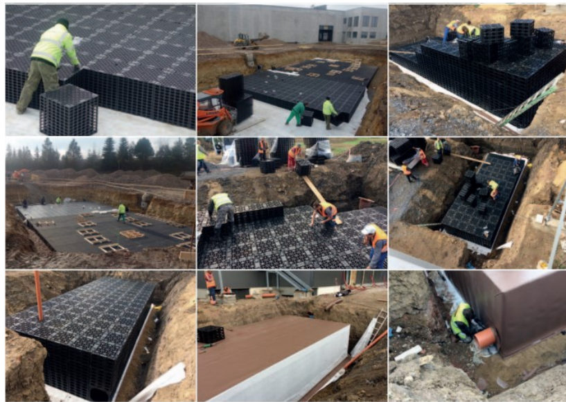
Obr. č. 16. Ukázka z realizace vsakovacích a retenčních objektů (MEA water management, 2021)
