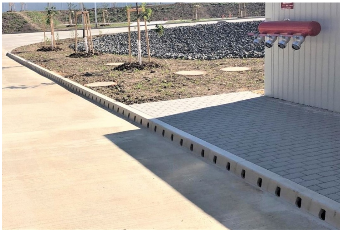
Obr. č. 13. Obrubníkové odvodnění (MEA water management, 2021)
