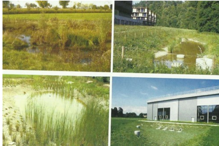
Obr. č. 10. Vsakovací jámy (Hlavínek, 2007)
