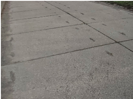
Obr. č. 5. Vozovka ze silničních dílců (Zajíček, 2021)
