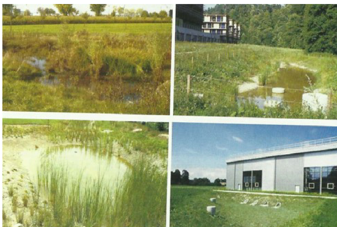
Obr. č. 10. Vsakovací jámy (Hlavínek, 2007)
