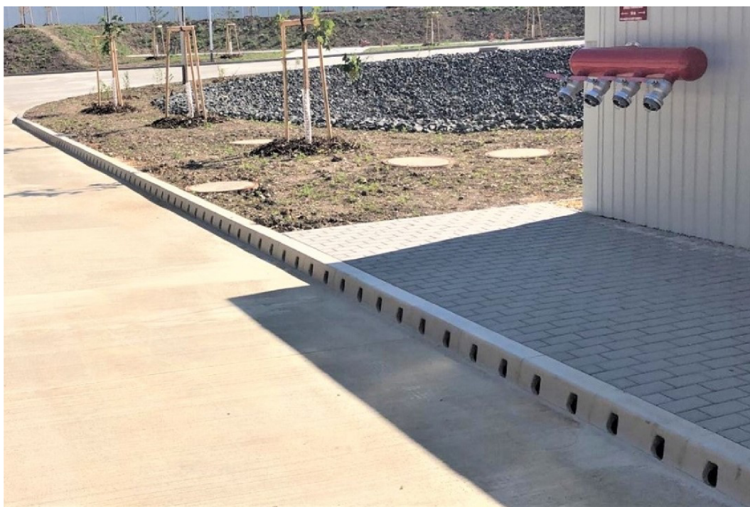
Obr. č. 13. Obrubníkové odvodnění (MEA water management, 2021)
