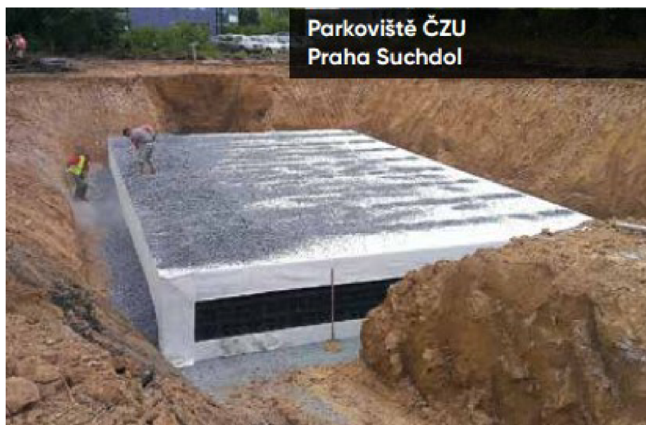
Obr. č. 17. Ukázka z realizace vsakovacích a retenčních objektů (Nikoll, 2021)
