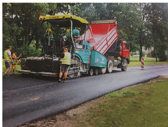
Obr. č. 3. Pokládka asfaltové vozovky (Zajíček, 2021)
