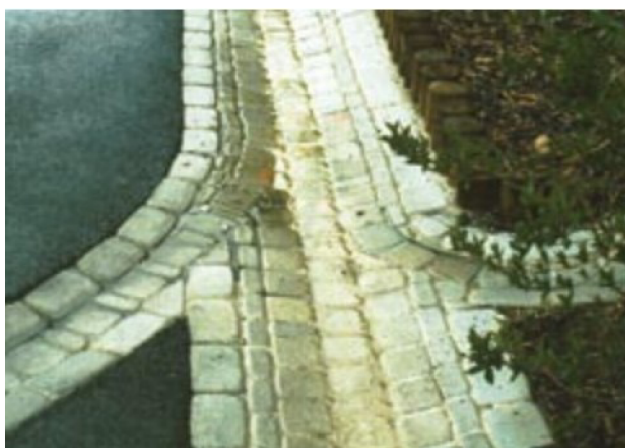
Obr. č. 7. Odvodňovací rigol (Meißner, 2006)
