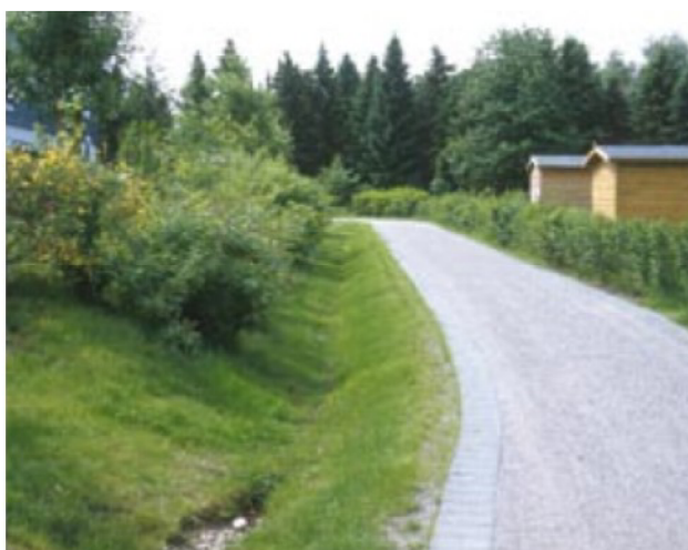
Obr. č. 8. Odvodňovací příkop podél komunikace (Meißner, 2006)
