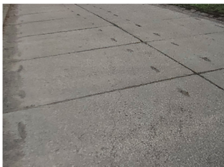
Obr. č. 5. Vozovka ze silničních dílců (Zajíček, 2021)
