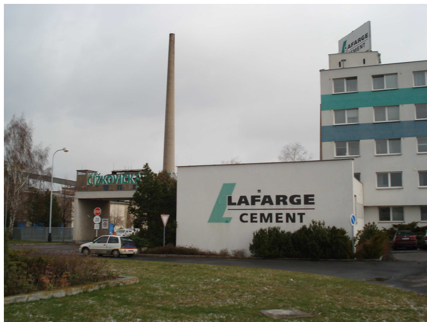
Obr. č. 17 Cementárna Lafarge cement, a.s. v Čížkovicích
