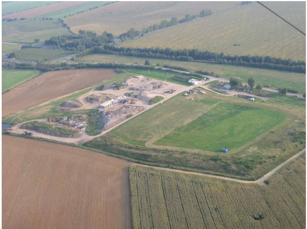
Obr. č. 4 Areál Křižné cesty v Buchlovicích
