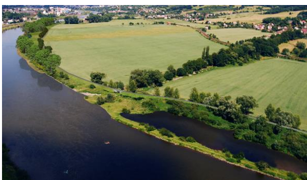
Příloha 15 Navýšení podélné hráze nad ústím toku Kamenička ŘKM 745,5-745,7 ŘVC, 2012
