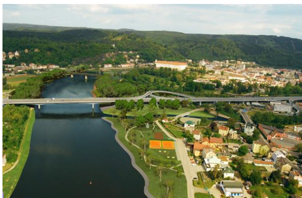
Příloha 12 Revitalizace v ústí Ploučnice ŘKM 740,92-741,78 ŘVC, 2012
