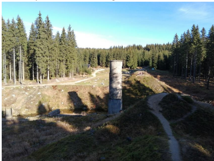
Obrázek č. 15: Fotografie hráze a šoupátkové věže. Zdroj: Fotografie autora z roku 2020.
