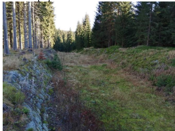
Obrázek č. 13: Uměle vytvořený odtokový kanál, kudy měla voda z nádrže odtékat přes přepad. Na snímku je viditelné vrůstání rostlin do prostoru vyskládaného z kamenů. Zdroj: Fotografie autora z roku 2020.
