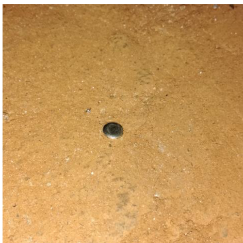
obr. 5 a obr. 6 Stabilizace PMS uvnitř objektu
