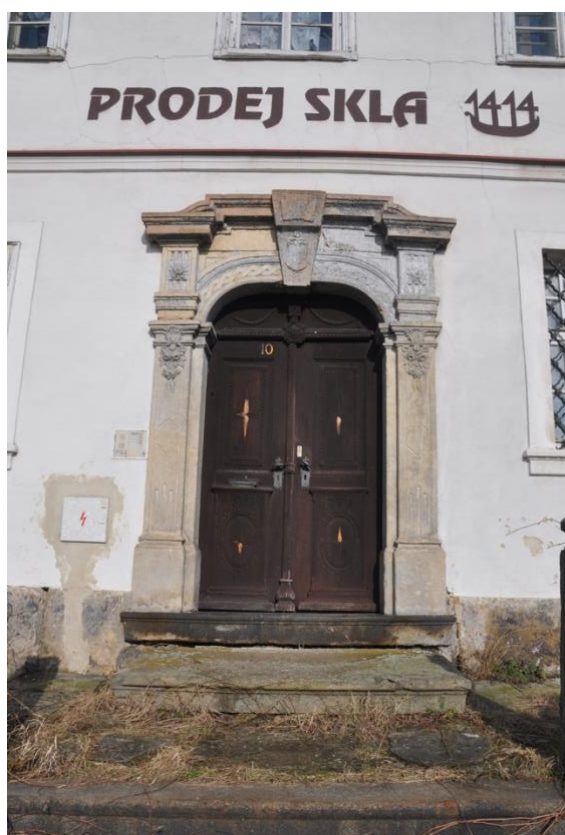
Obrázek 10. Vchodový portál vstupních dveří penzionu Zdroj: vlastní
