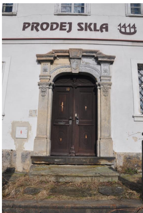
Obrázek 10. Vchodový portál vstupních dveří penzionu Zdroj: vlastní
