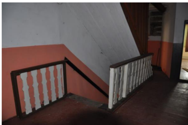
Obrázek 13. Schodiště v budově Zdroj: vlastní
