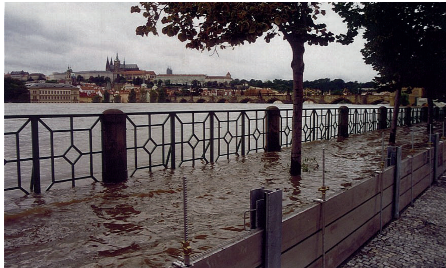
Obr. 12 Mobilní stěny při povodni 2002, Praha https://www.chmi.cz/
