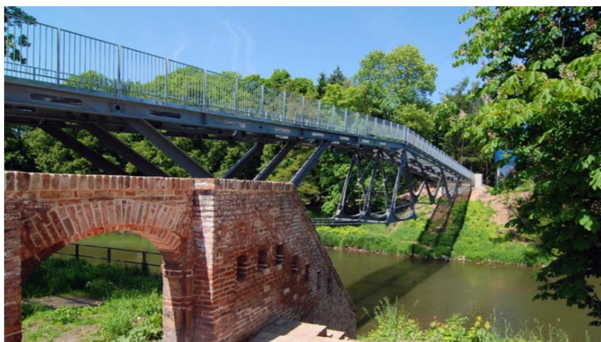
22 Boční pohled na most a zbytky fortifikačního opevnění (Zdroj: ©Šmídek)
