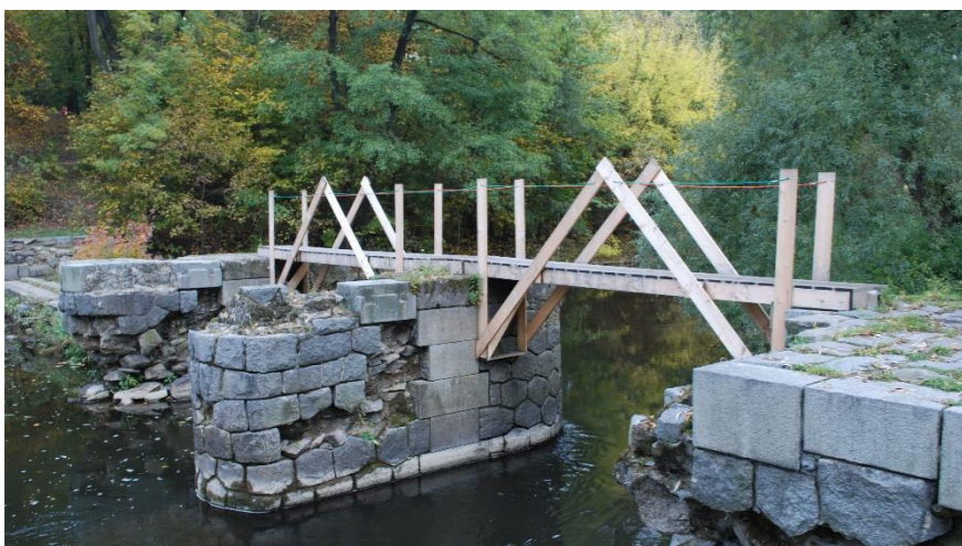
27 Zábradlí z barevných lan (Zdroj: ©Teplý)
