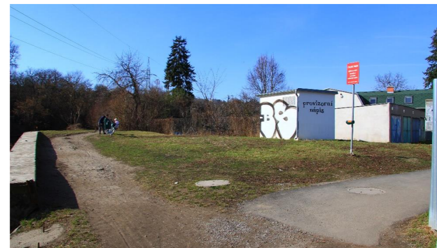
35 Elektrická rozvodna (Zdroj: autorka, 2017)
