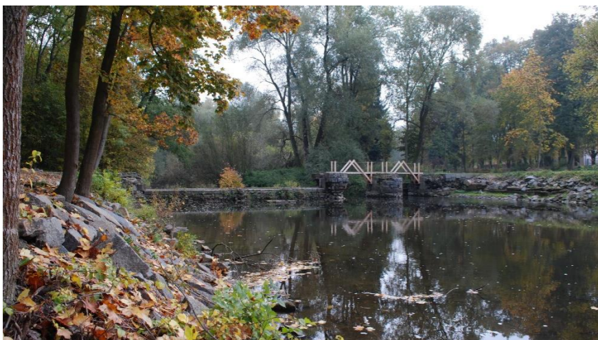
26 Jednoduchá, přitom efektní konstrukce lávky (Zdroj: ©Teplý)
