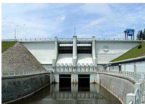
Obrázek č. 10 – Vodní elektrárna, Lipno n/Vlt
