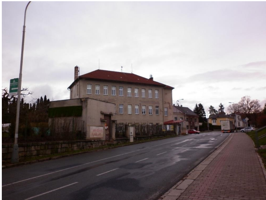
Obr. č. 6 Budova léčebny (vlastní zdroj)
