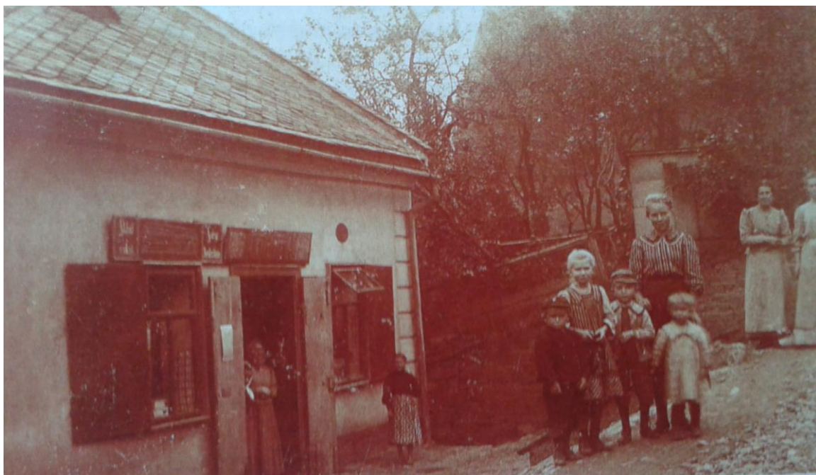
Obrázek č. 4: Soukromý dům s obchůdkem, byl původně sídlem staré velkobystřické školy 3
