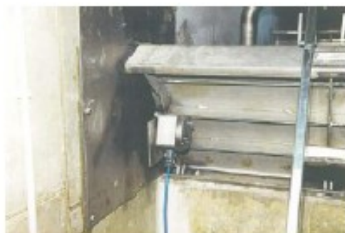
Čidlo úhlu natočení pro měření množství odlehčené vody
