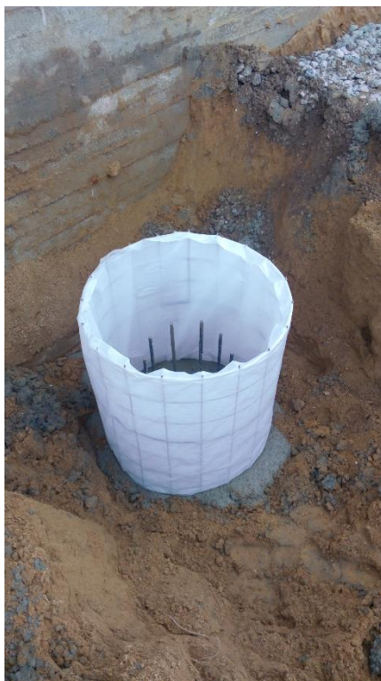
Obrázek 38 Bednění hlavice piloty
