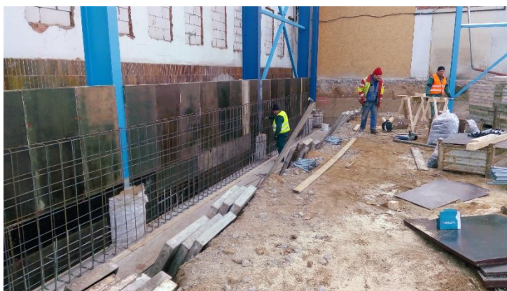
Obrázek 36 První etapa opěrných stěn
