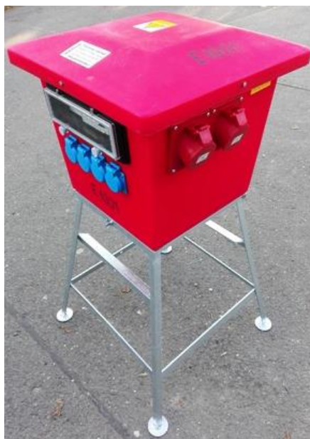
Obrázek 1 Hlavní staveništní rozvaděč
