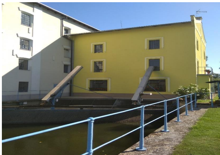
Obrázek 13 - Malá vodní elektrárna
