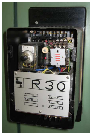
Obrázek 5.6 Elektromechanická diferenciální ochrana R30, n.p. ZPA Trutnov
