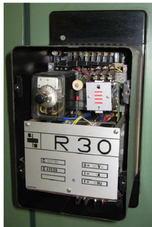
Obrázek 5.6 Elektromechanická diferenciální ochrana R30, n.p. ZPA Trutnov
