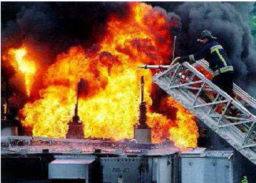
Obrázek 3.1 Požár transformátoru [7]
